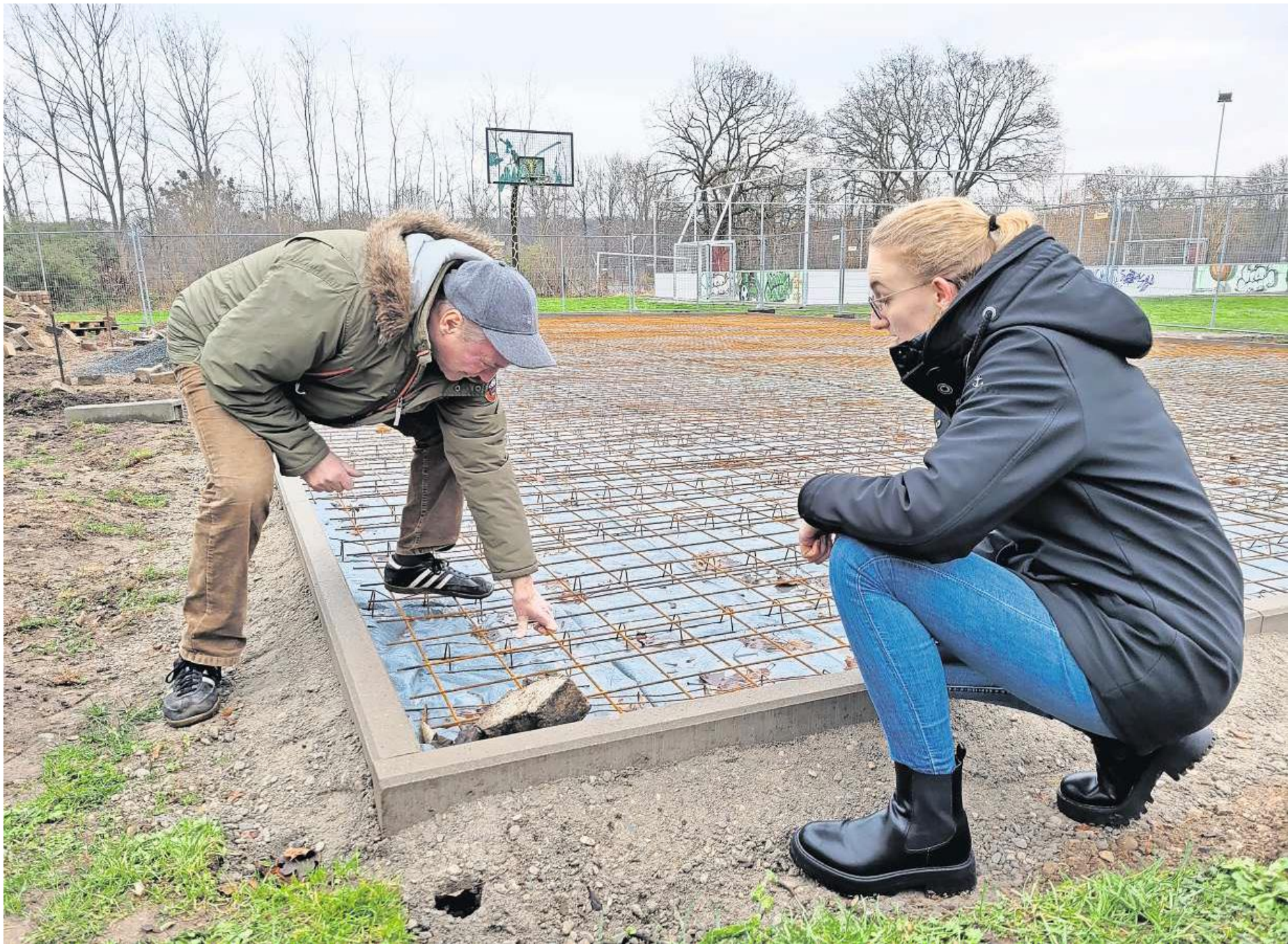
Der frühere Stadtjugendpfleger Jörg Aschemann und Alena Sydow von Labora begutachten am Montag die Baustelle. FOTO: CHRISTIAN HARBORTH
